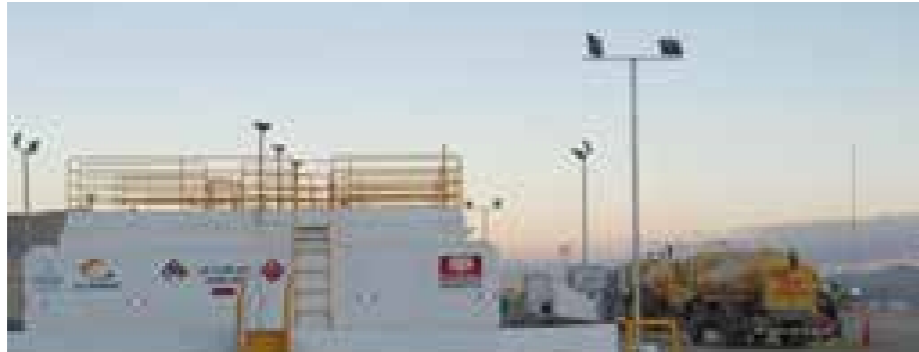
Alquiler de estaciones de combustible
