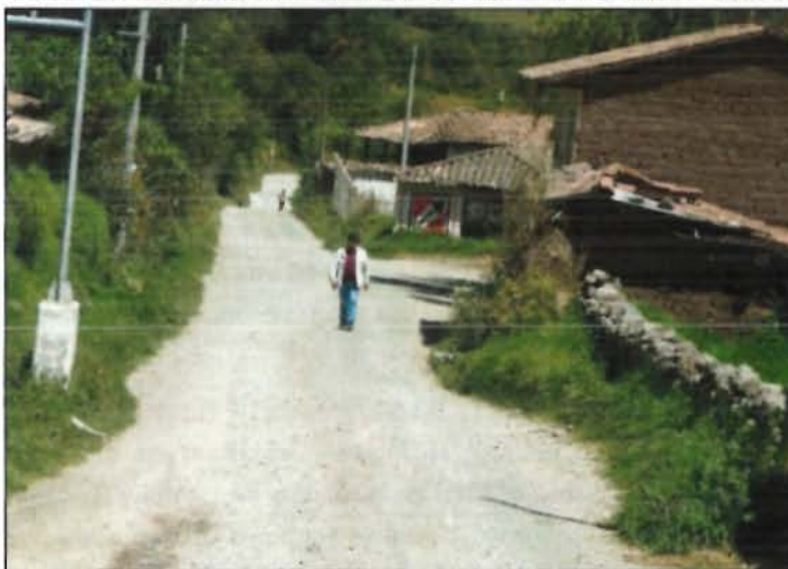
FOTO 12. CARRETERA AFIRMADA CU-117 BICAPA SIMPI – ACOS
