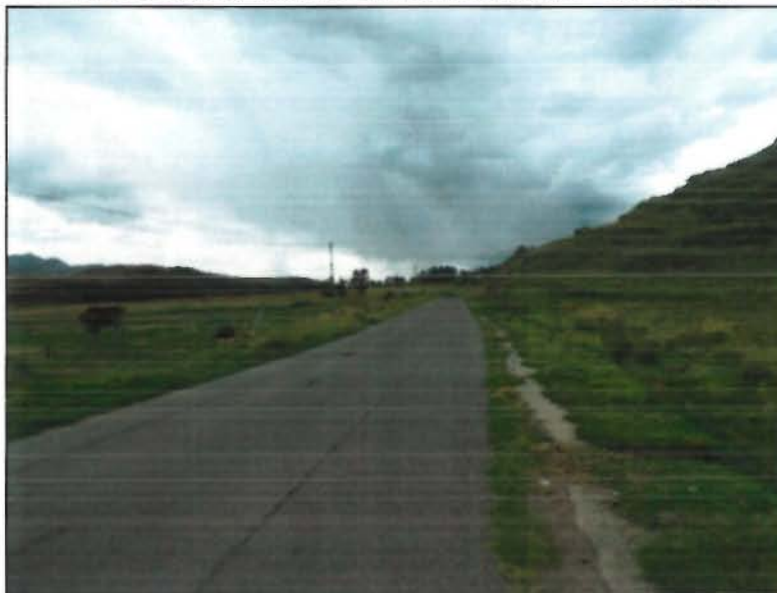
FOTO 8. CARRETERA ASFALTADA SANGARARÁ – ACOMAYO
